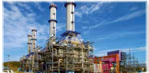
YENI ELEKTRİK 865MW CCPP-TURKEY
